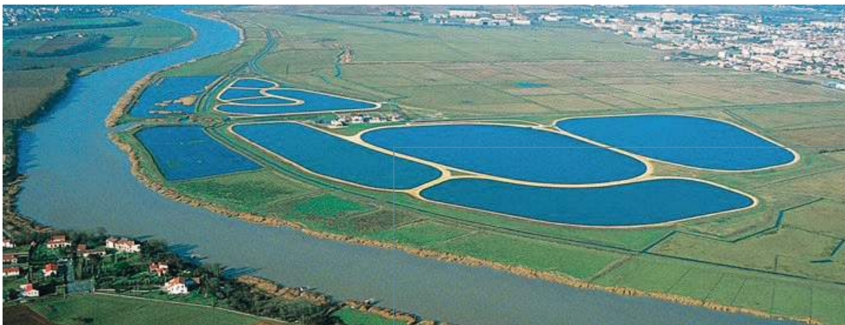
La station de lagunage de Rochefort
