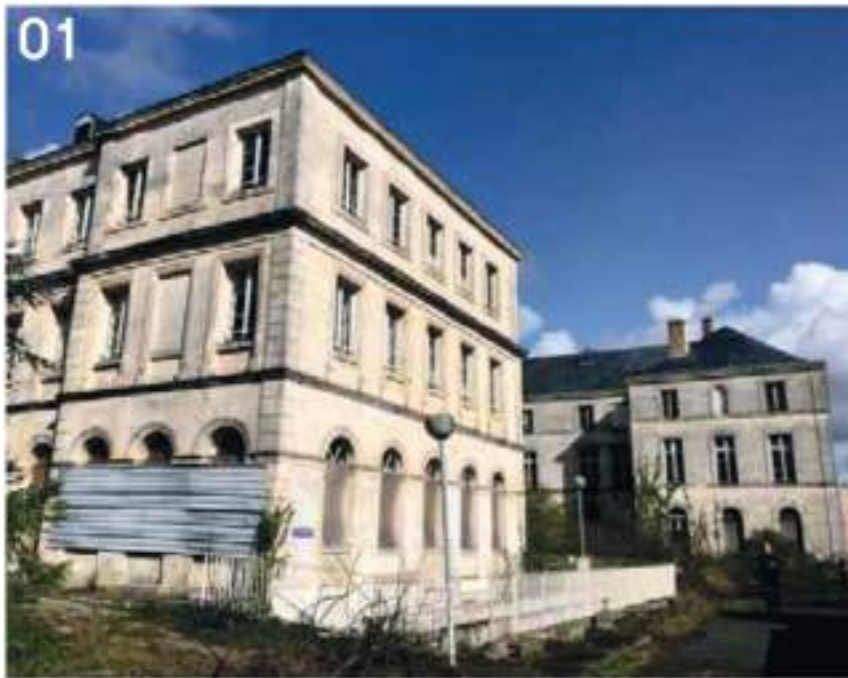
MAS : Ancienne maison d'accueil spécialisée. Bâtiment de style classique du XIX ème Siècle situé Rue Ernest Renan, en R+2. Infrastructure conservée et mise en valeur en Résidence Services Seniors .
