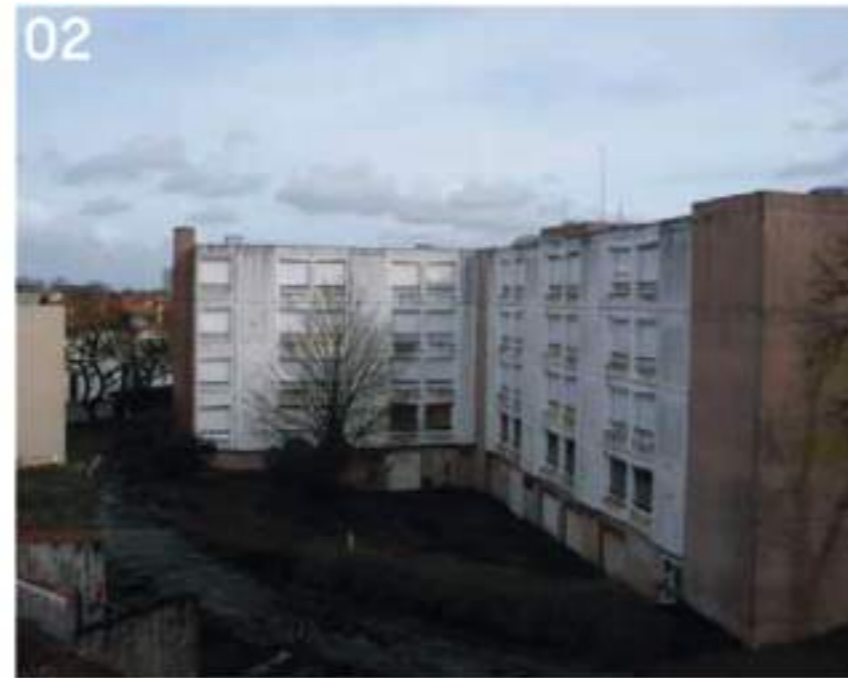
V240 : Ancien centre de gérontologie de Rochefort. Bâtiment des années 70 situé Rue des Fleurs, en R+3. Infrastructure conservée et restructurée en appartements de standing .
