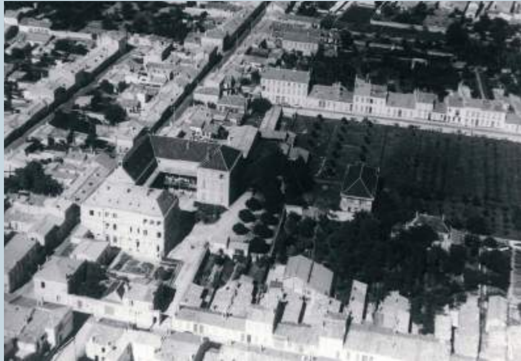
Chaque corps de bâtiment a reçu un traitement architectural de facture différente.
