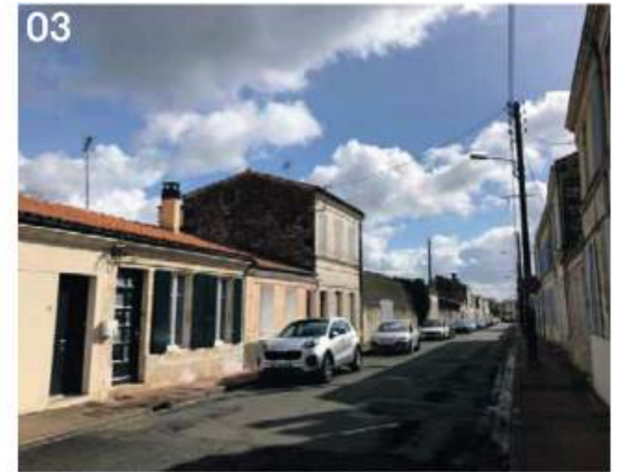
Maisons de ville : petites maisons alignées sur rue, accolées les unes aux autres, avec jardins en cœur d'îlot sur fond de parcelle (bâtiments en RDC ou R+1). Construction de 8 Maisons de ville.
